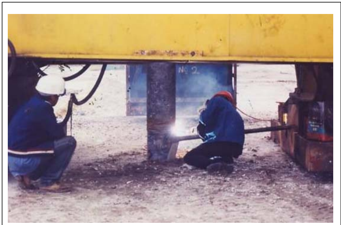
Foto 4.2 : Hujung Pile Disambung Dengan Kaedah Welding
