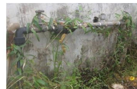
Plat B6: Jenis-jenis sambung dari paip utama ke meter pengguna
