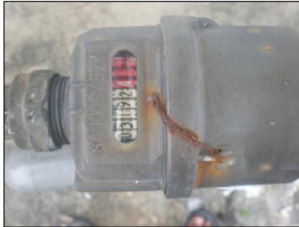
Rajah 2.7: Meter air jenis Kent PSM
