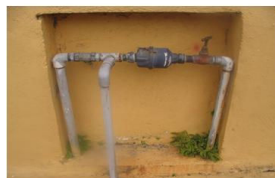
Plat B6: Jenis-jenis sambung dari paip utama ke meter pengguna
