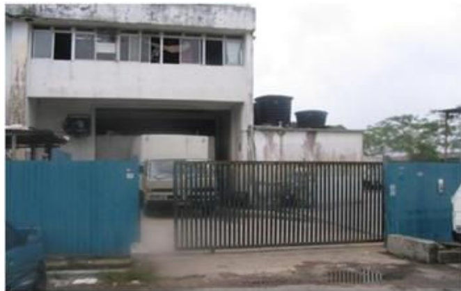
Plat B4: Penggunaan air harian yang tinggi kilang ATLAS
