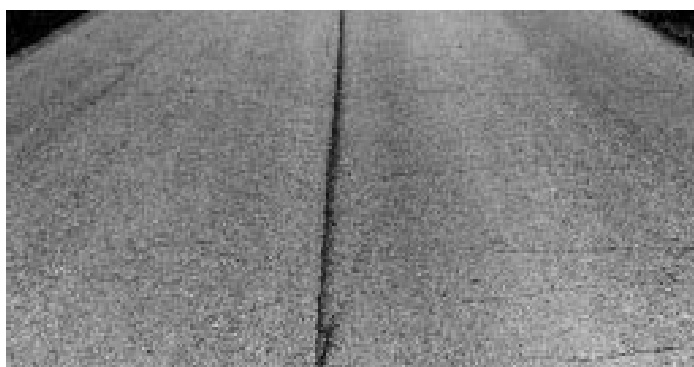
Rajah 2.4: Gambarajah retak memanjang
