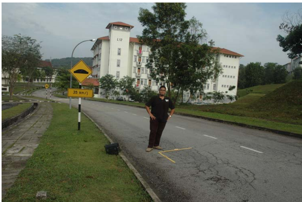
Rajah 3.7: Jalan Merbau di antara kawasan letak kenderaan Fakulti Kejuruteraan Awam dan Blok L12, Kolej Tun Hussein Onn
