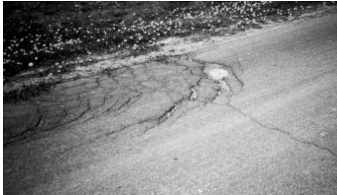
Rajah 2.7: Gambarajah retak bulan sabit
