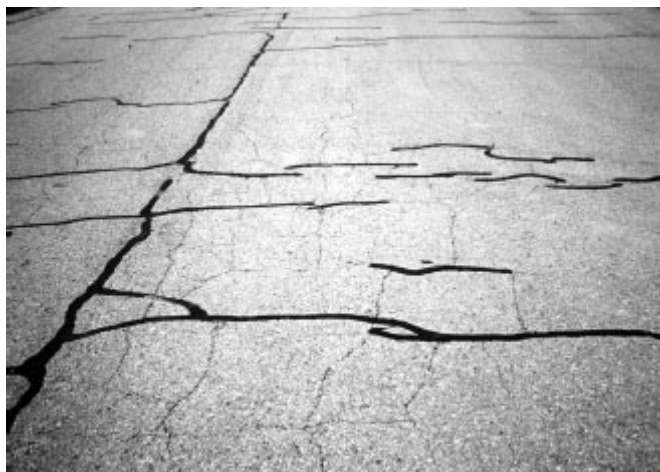
Rajah 2.6: Gambarajah retak blok
